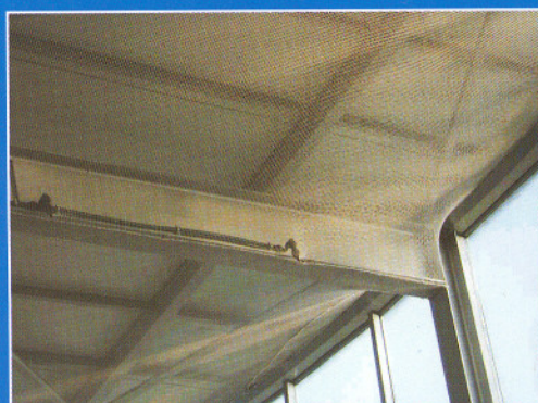
Zasíťování podhledu polyethylenovou sítí, oko 15x15mm, barva bílá, nerez kotvení. Bechyňův pavilon, pražská ZOO.
