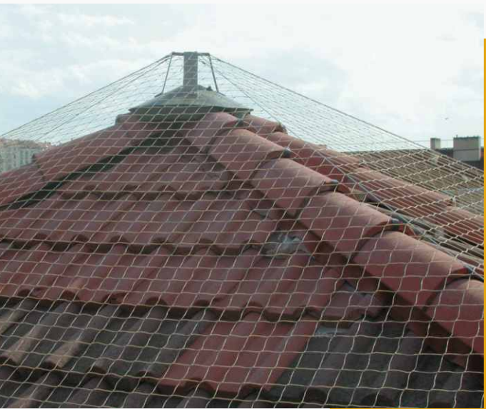
Plošné ošetření střechy sítí S051
